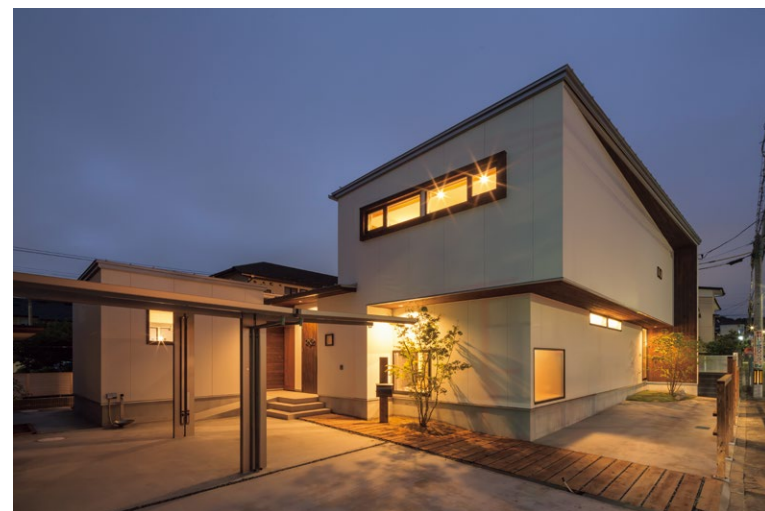
シンプルな箱形の外観フォルム。外周に大きな開口部がないので外の視線が気にならない
